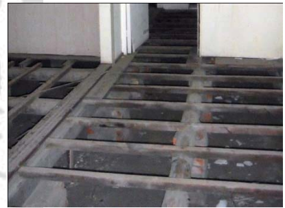
【圖 4-12】水交社志開新村日式宿舍基礎與地樑照片
