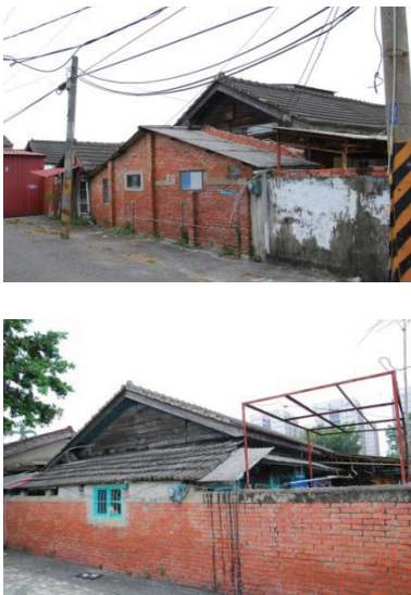
【圖 4-49】側邊增建 (上不規則形型；下：單斜屋頂型)
