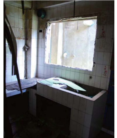
【圖 4-34】後院增建後的廚房內部 (精忠三村)
