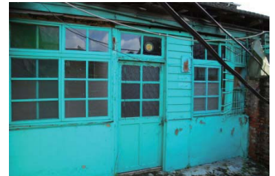
【圖 4-28】一般眷舍建築立面照片（上：面寬 3m，下：面寬 6m。）
