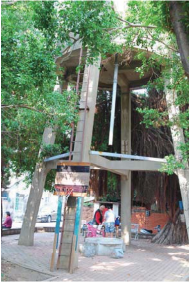
【圖 4-100】公園內大型水塔
