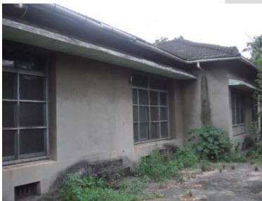
【圖 4-23】水交社日式宿舍正面開門與重簷構造。
