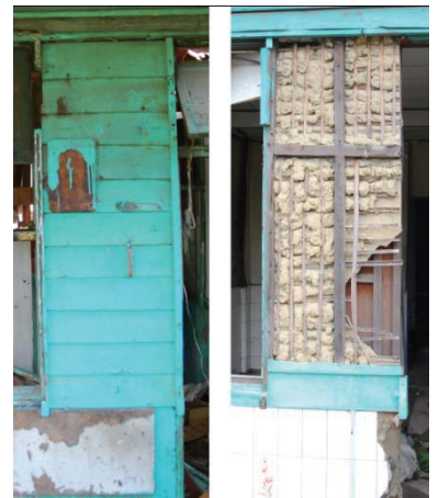
【圖 4-35】眷舍外牆雨淋板與外露的編竹泥牆（精忠三村）
