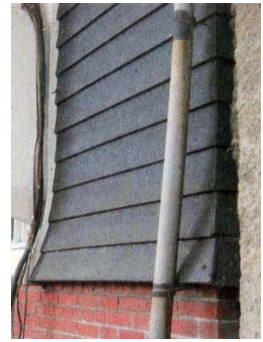
【圖 4-15】雨淋板照片 (圖片來源：張玉璜，2001：67。)
