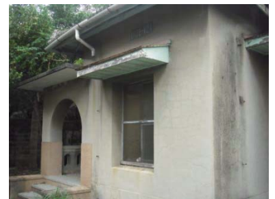
【圖 4-16】水交社志開新村日式宿舍水泥牆外觀
